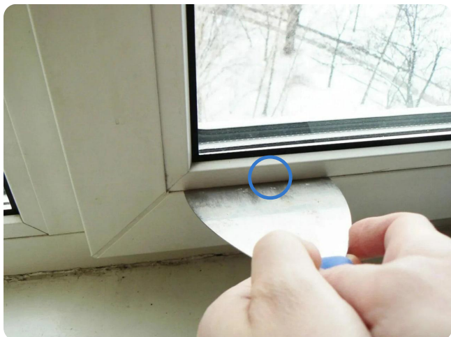
Шпатель входит в стык штапика с профилем.
